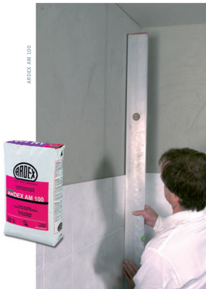
Неровные стены можно выровнять непосредственно перед укладкой плитки с помощью ARDEX AM 100.
