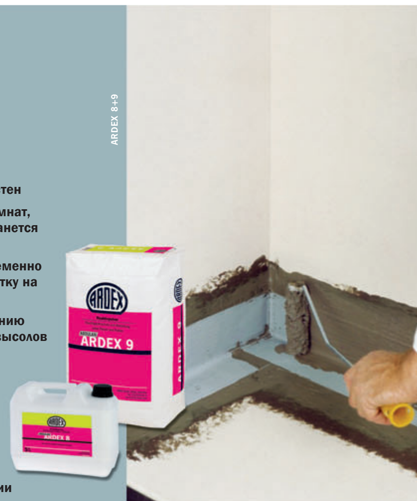
В зависимости от замешиваемой консистенции ARDEX 8+9 можно наносить шпателем, валиком или кистью.
