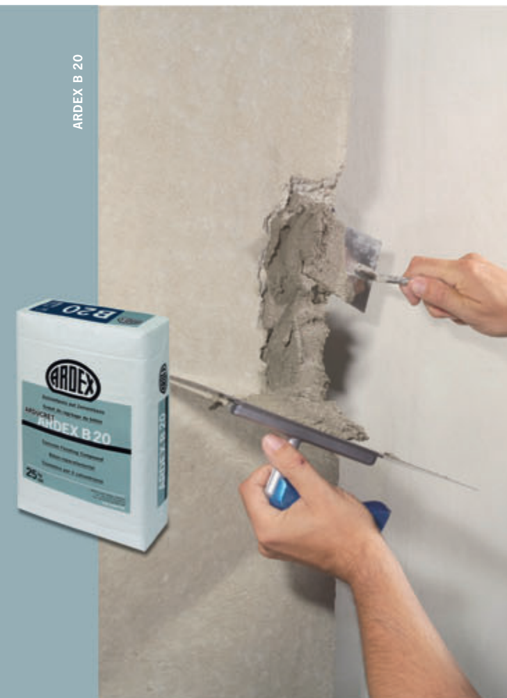
Устойчивый раствор наносится толстым и тонким слоем и твердеет прим. через 1 час.
